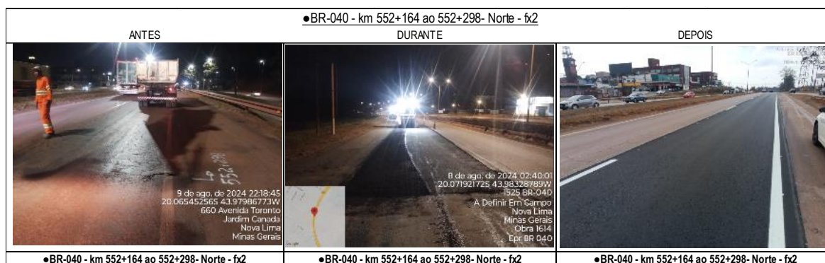
Figura 4: registro dos serviços nos KM 552+164 ao 552+298 Norte.
