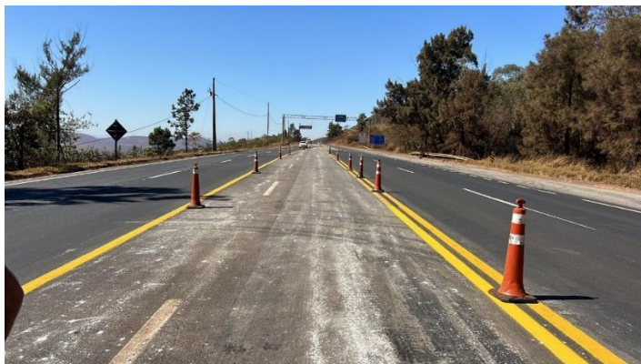
Figura 16: Serviço de requalificação da sinalização e do pavimento do Trevo da Moeda.
