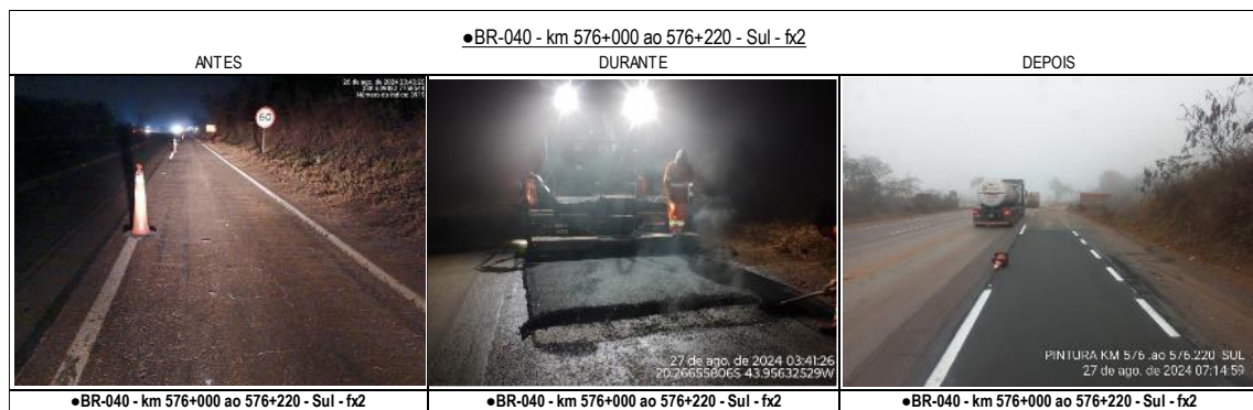
Figura 9: registro dos serviços nos KM 576+000 ao 576+220 Sul.
