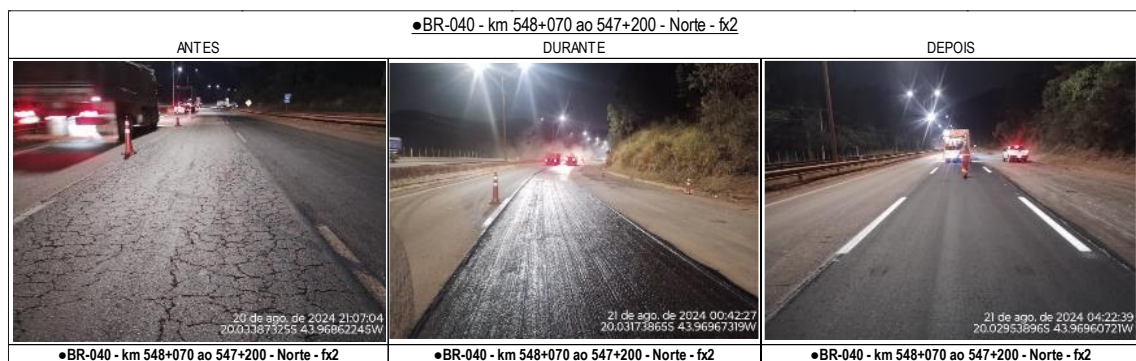
Figura 7: registro dos serviços nos KM 548+070 ao 547+200 Norte.
