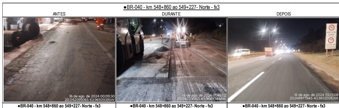
Figura 6: registro dos serviços nos KM 548+860 ao 549+277 Norte.
