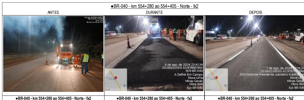
Figura 3: registros dos serviços nos KM 554+280 ao 554+405 Norte.
