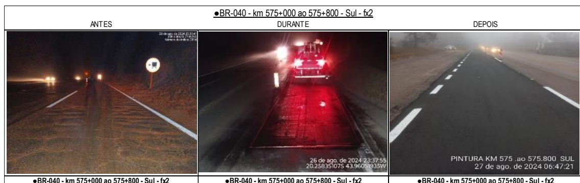
Figura 8: registro dos serviços nos KM 575+000 ao 575+800 Sul.
