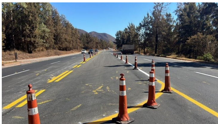
Figura 15: serviço de requalificação da sinalização e do pavimento do Trevo da Moeda.
